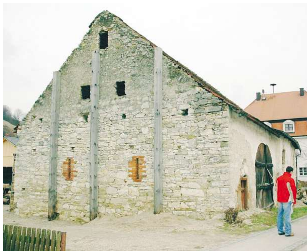
Die Westseite des Hauses musste schon vor einiger Zeit abgestützt werden.
